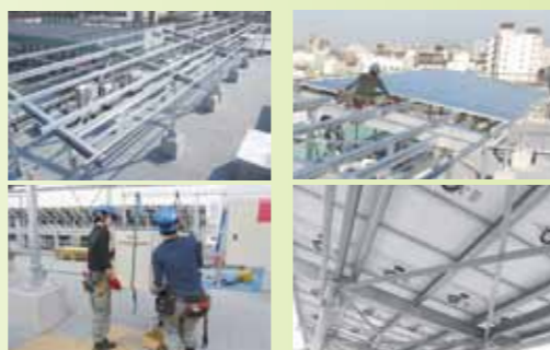
建設中の様子
