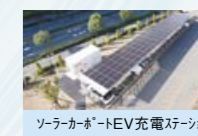
ソーラーカーポートEV充電ステーション
