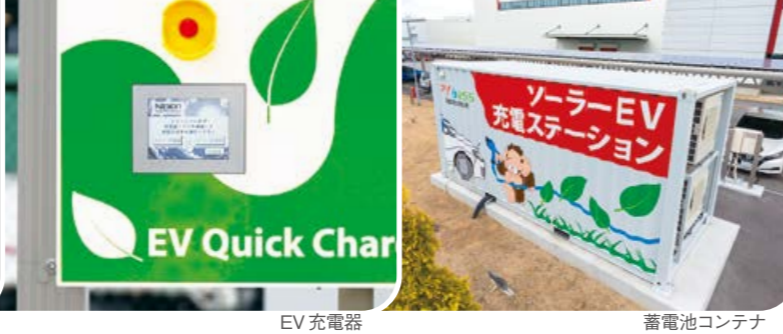
EV充電器 蓄電池コンテナ
